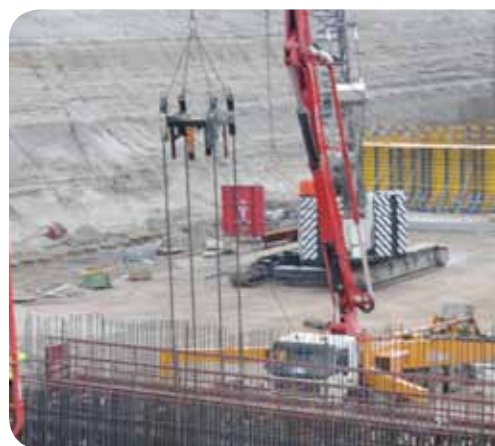
Die Aufhängekonstruktion im Einsatz: Mit einem Kranhub können vier Vibratoren gleichzeitig in den Beton eingetaucht werden – für eine effiziente, großflächige Verdichtung.
