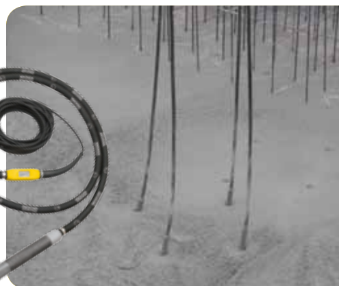
Die Aufhängekonstruktion im Einsatz: Mit einem Kranhub können vier Vibratoren gleichzeitig in den Beton eingetaucht werden – für eine effiziente, großflächige Verdichtung.
