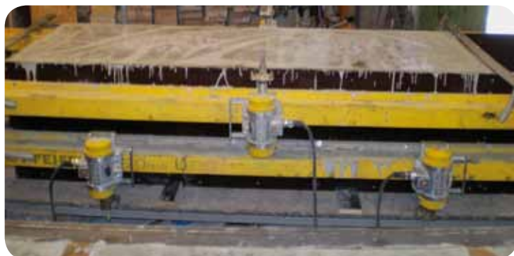
Karl-Heinz Kleih baut seine Schalungen selbst: Damit erzielt er auch mit der neuen Außenrüttlerausrüstung beste Ergebnisse.
